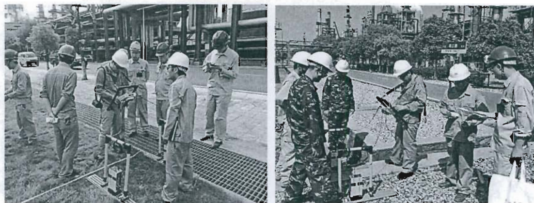
图 5.1 地下管线探查与现场确认
