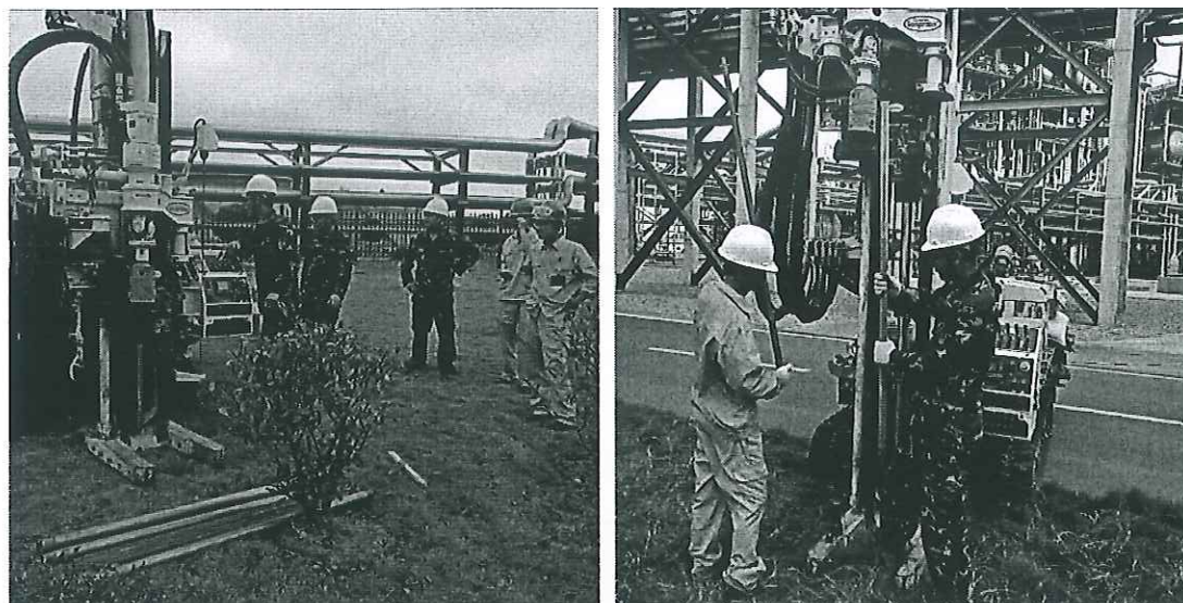
图 5.2 现场土壤钻孔及取样
